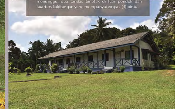
Bangunan lama ini menempatkan sebuah pondok polis dengan satu lokap, satu ruang pejabat, tempat menunggu, dua tandas terletak di luar pondok dan kuarters kakitangan yang mempunyai empat (4) pintu.
