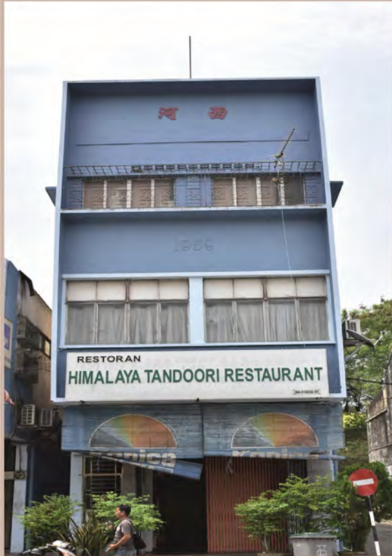
Sebahagian kedai yang fasad bangunannya telah diubah suai dengan menambah ketinggian daripada dua (2) kepada tiga (3) tingkat. Hal ini menyebabkan skala asal bangunan telah berubah.
