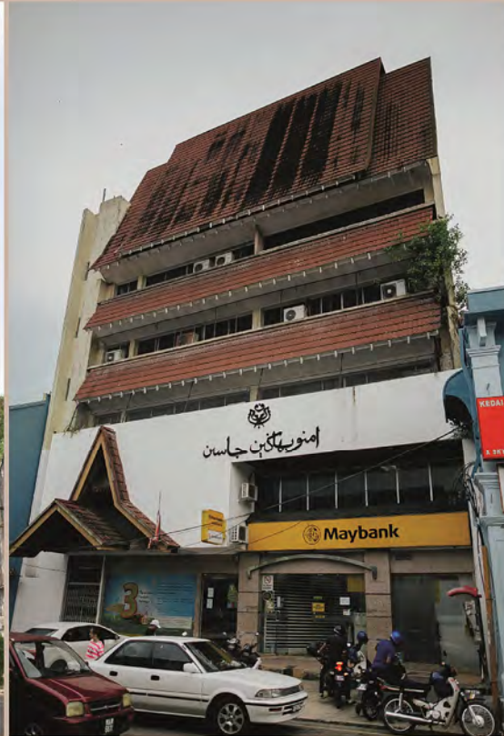
Sebahagian kedai yang fasad bangunannya telah diubah suai dengan menambah ketinggian daripada dua (2) kepada tiga (3) tingkat. Hal ini menyebabkan skala asal bangunan telah berubah.
