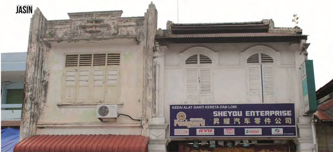
Bangunan kedai yang dibina pada tahun 1932.
