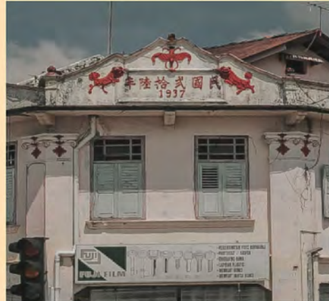
Bangunan kedai yang dibina pada tahun 1937.
